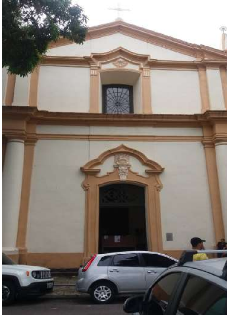
Figura 20: Fachada da Capela São João Batista. Fonte: Gabriela Araújo, 2016.
