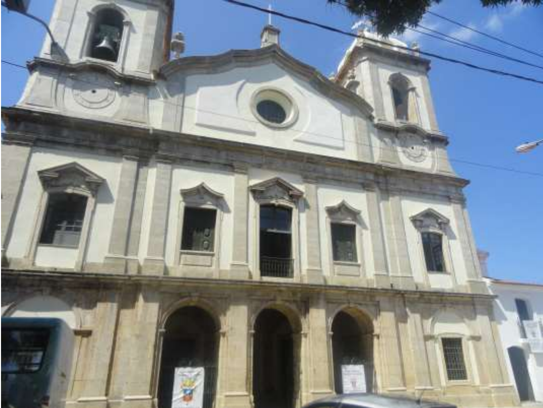
Figura 24: Fachada da Igreja Nossa Senhora do Carmo, após a restauração. Fonte: Gabriela Araújo, 2015.
